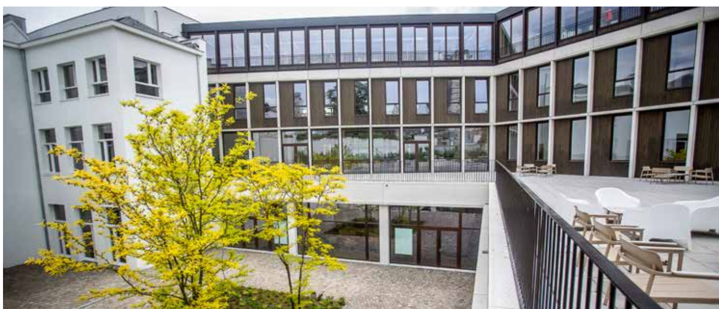
Campus Boogkeers: een voorbeeld van duurzame transformatie.
